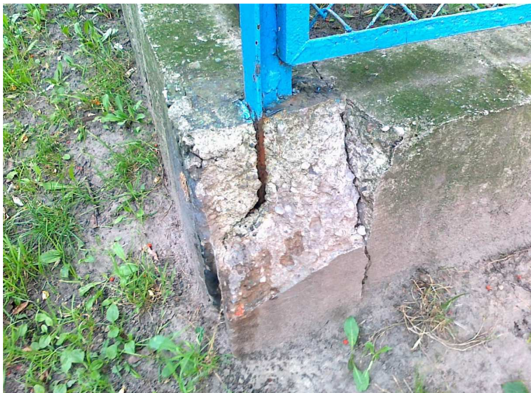
FOT. NR 4 WIDOK STOPNIA DEGRADACJI ISTNIEJĄCEGO OGRODZENIA
