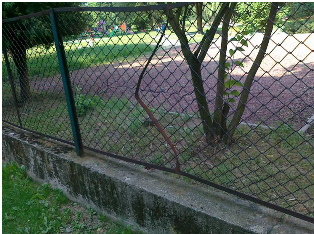
FOT. NR 6 WIDOK STOPNIA DEGRADACJI ISTNIEJĄCEGO OGRODZENIA
