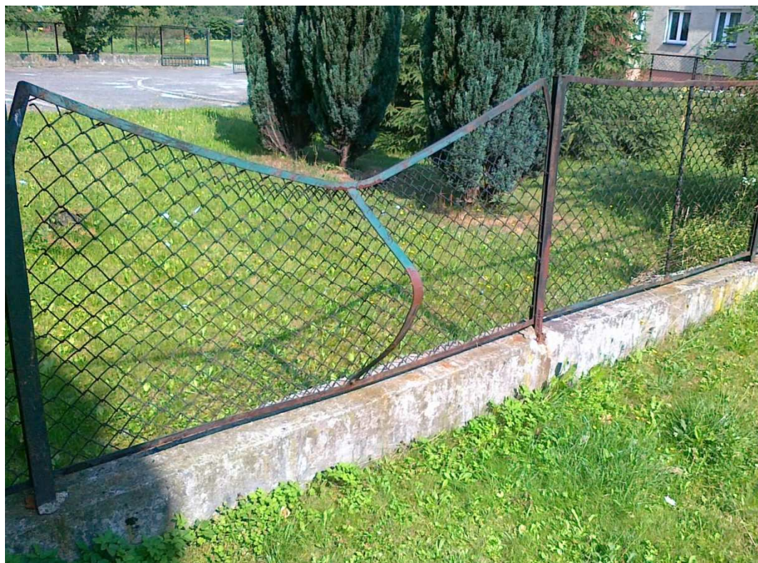
FOT. NR 2 WIDOK STOPNIA DEGRADACJI ISTNIEJĄCEGO OGRODZENIA
