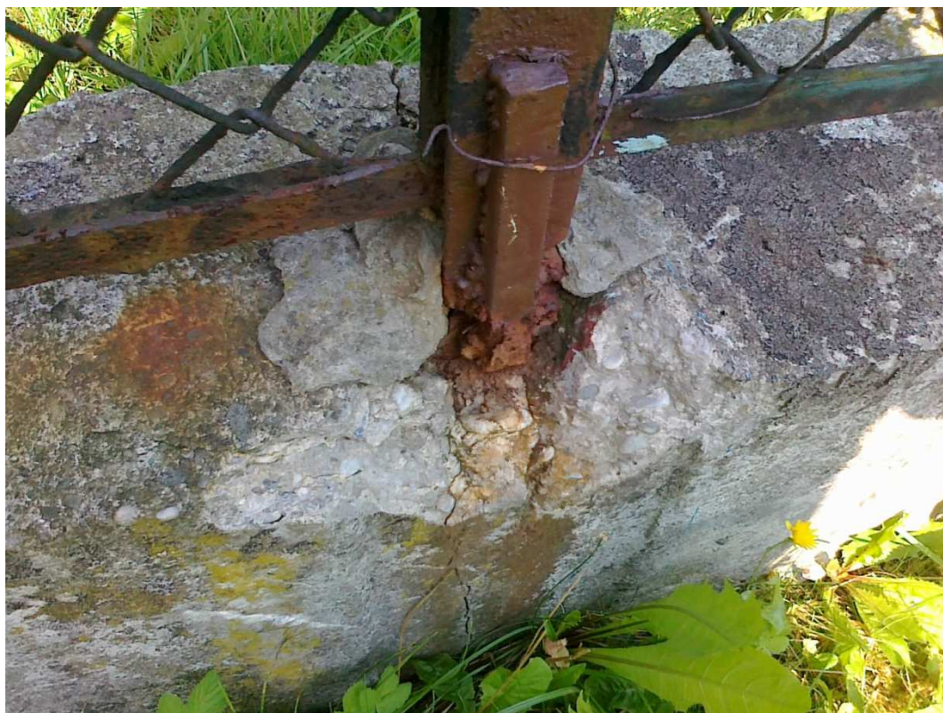
FOT. NR 4 WIDOK STOPNIA DEGRADACJI ISTNIEJĄCEGO OGRODZENIA
